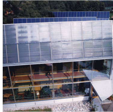
Ηλιακή μονάδα για θέρμανση νερού σε συγκρότημα κατοικιών, JJ-Fuxgasse, Gleisdorf, Αυστρία
